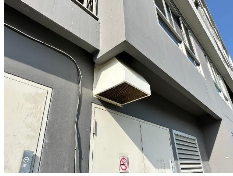
ภาพที่ 2-71 พัดลมระบายอากาศ
