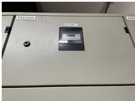
ภาพที่ 2-12 มิเตอร์ไฟฟ้าระบบบำบัดน้ำเสีย
