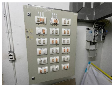
ภาพที่ 2-85 สวิตช์ไฟแยกไฟส่องสว่าง
