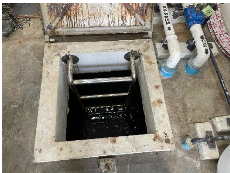
ภาพที่ 2-11 ถังเก็บน้ำสำรอง อาคาร A และ อาคาร B
