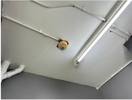
ภาพที่ 2-49 Heat Detector
