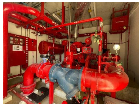
ภาพที่ 2-43 เครื่องสูบน้ำดับเพลิง
