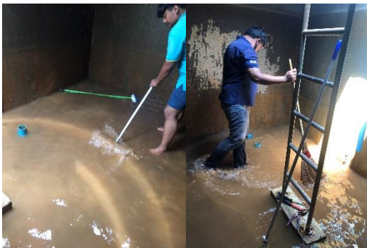
ภาพที่ 2-40 ทำความสะอาดถังเก็บน้ำสำรอง
