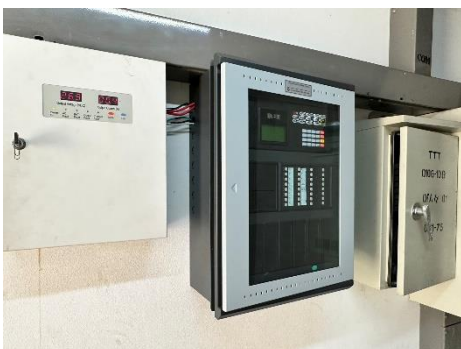
ภาพที่ 2-47 FCP (แผงควบคุม รับ-ส่งสัญญาณทั่วอาคาร)
